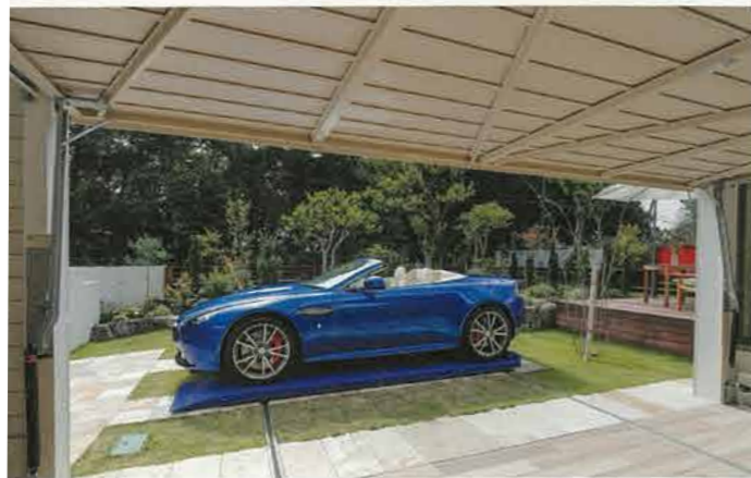
横移動タイプのリフトをオーダーメイドしている。市街化調整区域の建築基準に合わせるための工夫であるとともに、見た目にも個性的かつ特徴のあるガレージとなっている。
